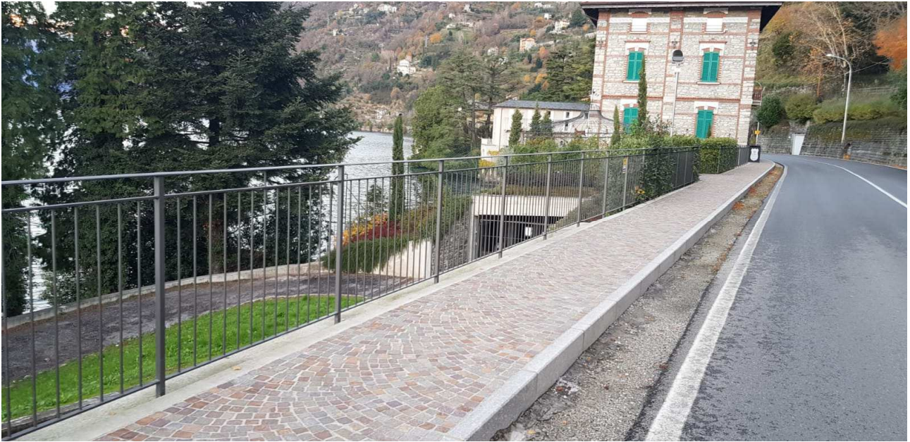
Esempio marciapiede proprietà Pozzoli
